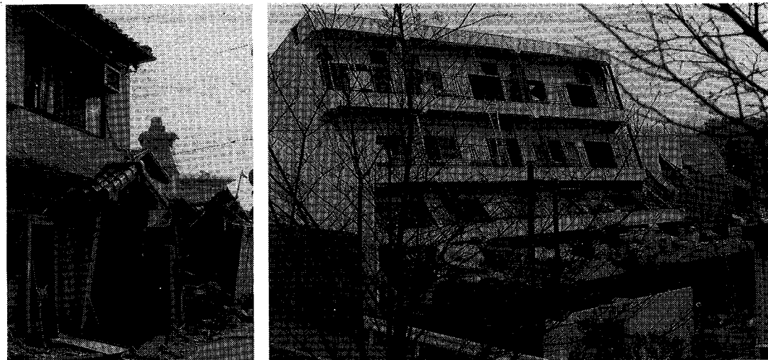
阪急神戸線夙川駅付近の被災の様相 (平成7年2月26日 川畑 泰撮影)
